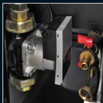
Integrierte Umwälzpumpe für die Heizanlage
